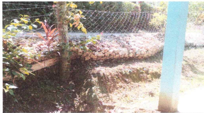
Foto 3: Levantamiento de muro perimetral 92 ML
