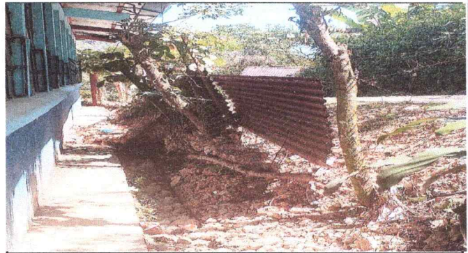
Foto 2: Levantamiento de muro perimetral 92 ML
