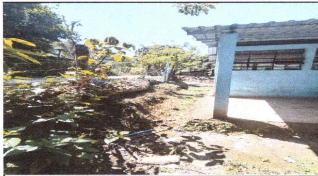
Foto 1: Canaletas para captacion de agua
