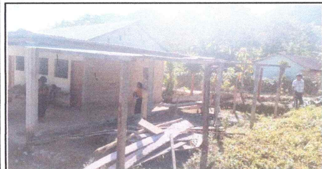
Foto 5: Cambio de techo y aplicación de pintura
